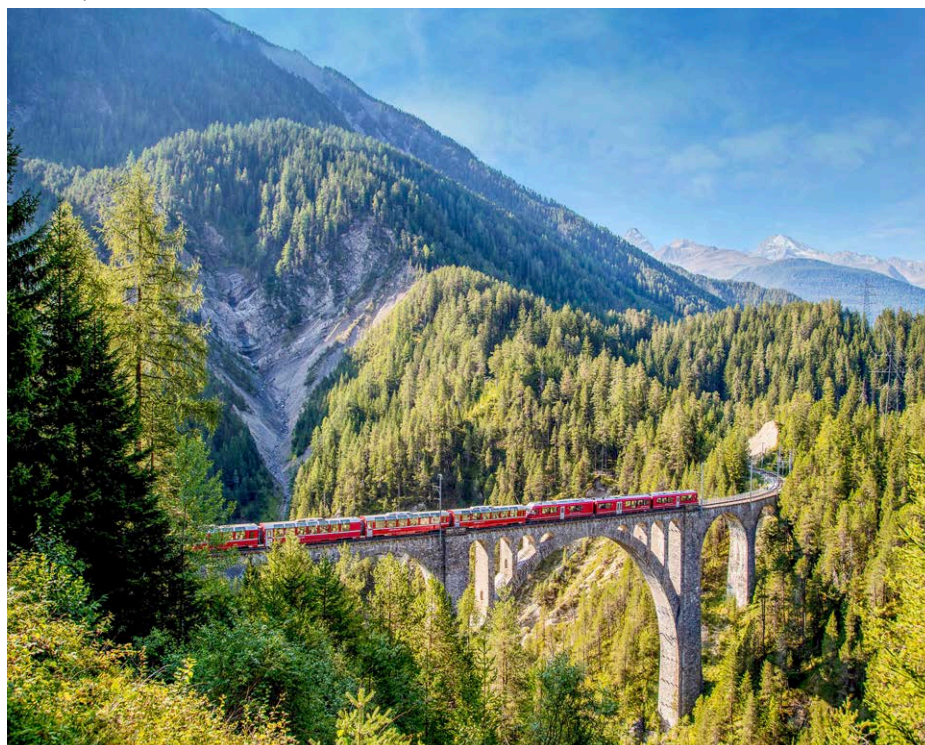
Bernina Express auf dem Wiesner Viadukt
